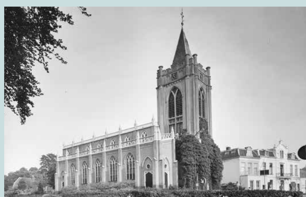
'Oude Kerk' (restauratie), 1e Dorpsstraat 1 J. Stuivinga, 1909
