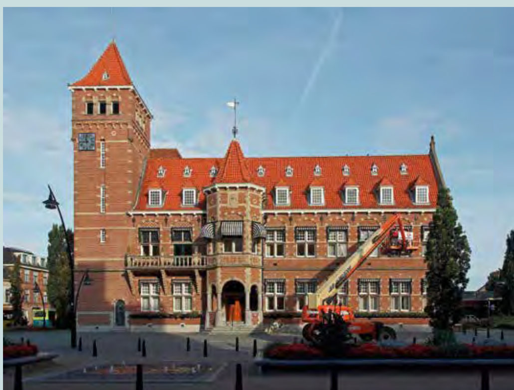
Raadhuis, Het Rond 1 J. Stuivinga (nieuwbouw), 1907 J. & Th. Stuivinga (uitbreiding), 1938
